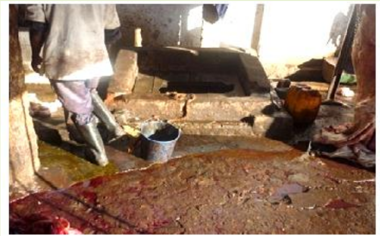
Puits et sol cimenté
